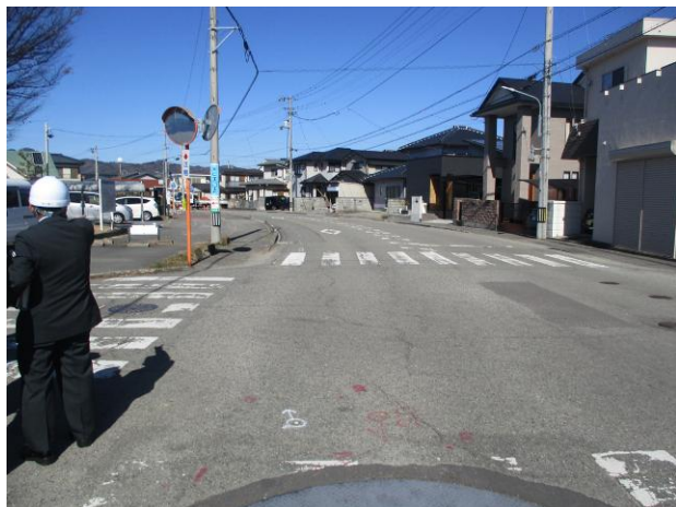
立坑 NO.12 から NO.15 方向
