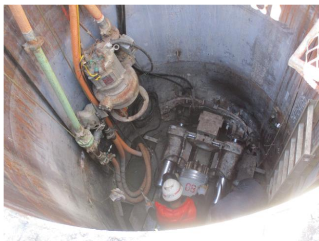
立坑 NO.13 推進工施工状況
