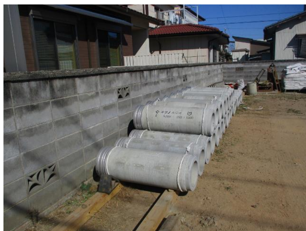
推進管仮置き状況
