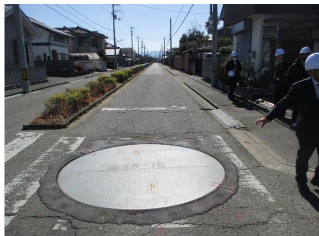
立坑 NO.12 から NO.6 方向
