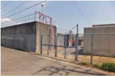
グリーンタウン下水処理場
