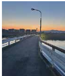
日没後の共栄橋より
