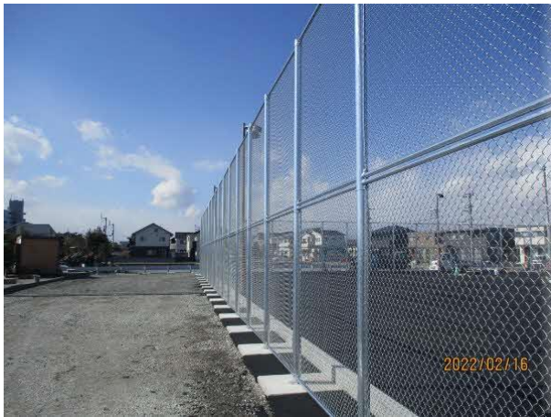
防球フェンス設置状況
