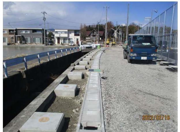
目隠し遮音フェンス・ U型側溝設置状況
