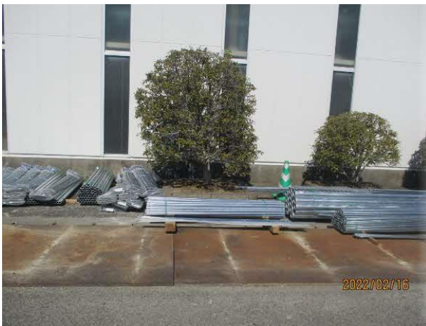
資材仮置き状況（りん木設置）
