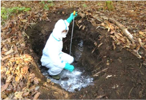
1) 2) 穴に消石灰を入れる
