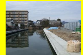
地蔵川護岸改修
