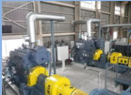
老門ポンプ場
