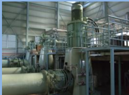
中央排水機場
