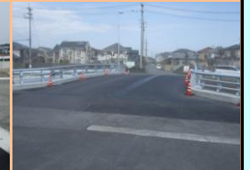
町道25号(老門橋)
