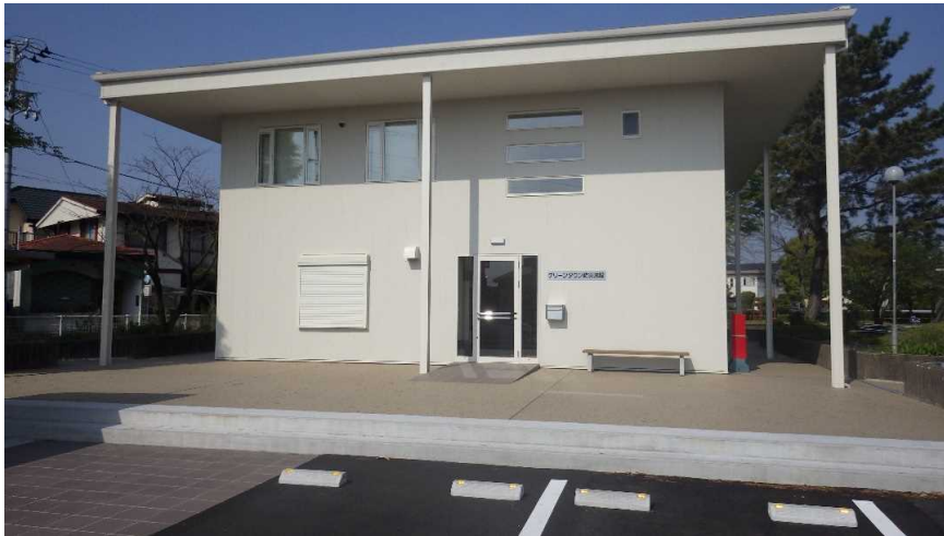
●グリーンタウン防災施設 平成28年1月竣工
