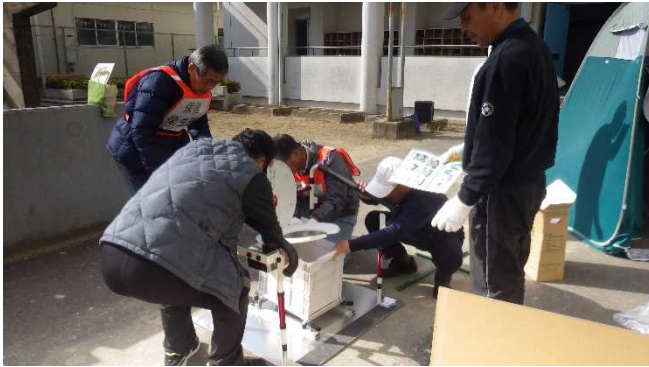
マンホールトイレ設置
